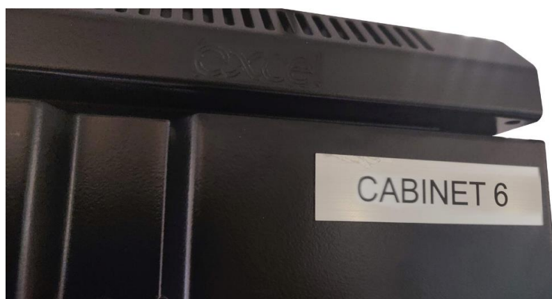
Rysunek 47 Oznaczenie szaf Punktu Dystrybucyjnego za pomocą etykiet
